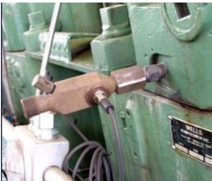
Gambar 89 Contoh Foto Pemasangan Kiene Valve
