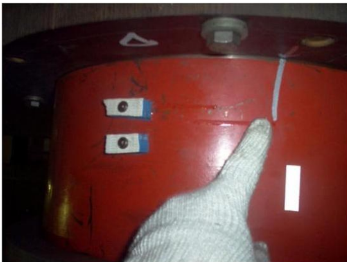
Gambar 79 Penanda TDC pada shaft dan penanda yang sudah terpasang
